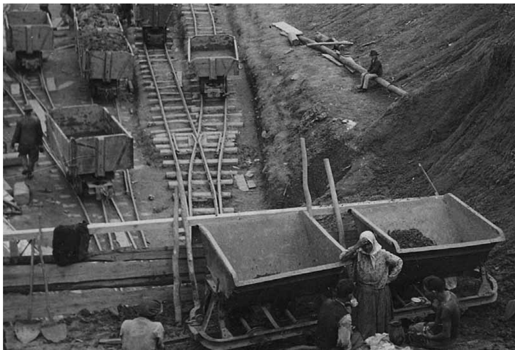
◆ Výstavba železničnej trate pri Hanušovciach n. Topľou.
