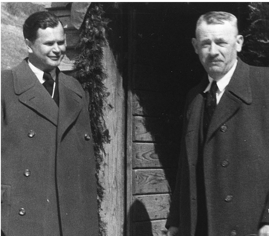
♦ Ing. Lozovský (vľavo) a Štefanec, majitelia firmy budujúcej 4. a 5. stavebný úsek železničnej trate Prešov-Strážske.
