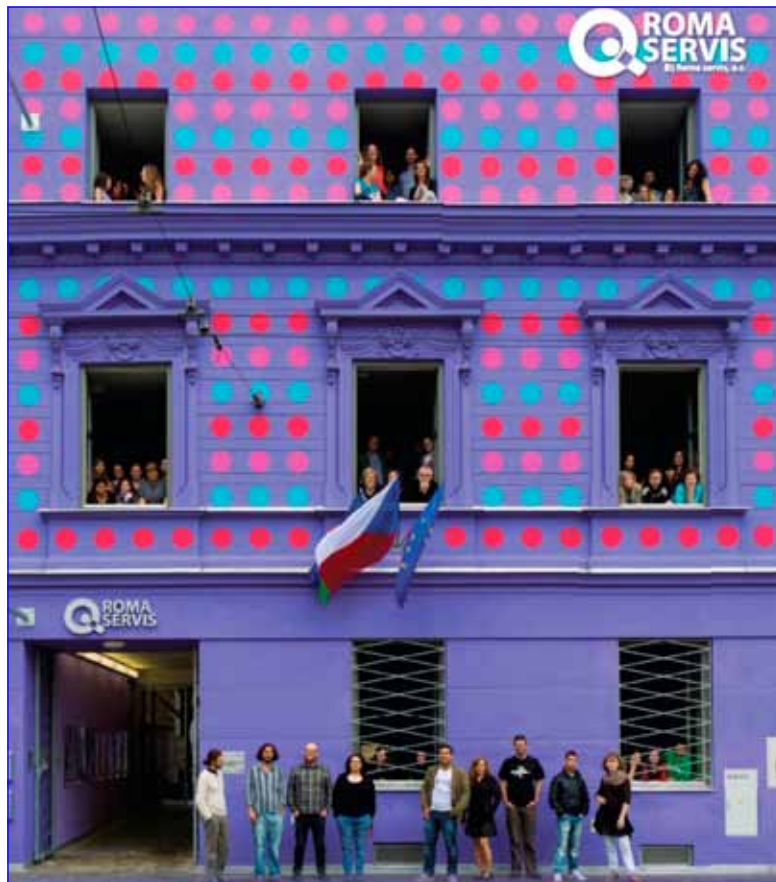
budova IQ Roma servis
