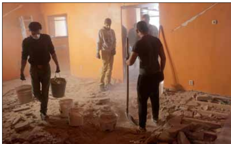
Rekonstrukce studia – svépomocná práce účastníků projektu na budování a rekonstrukci studia
